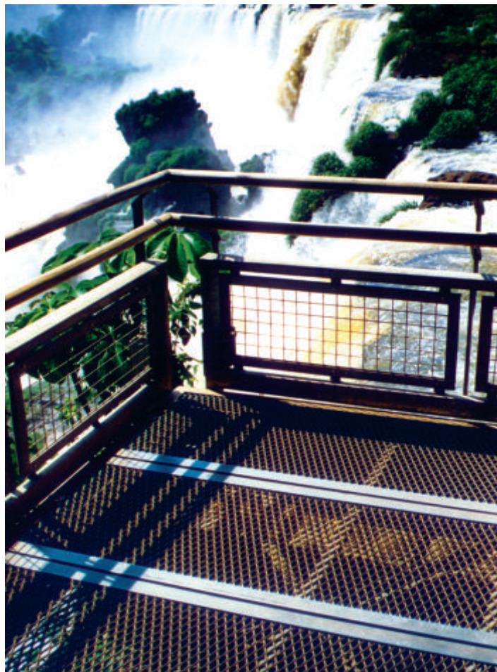
Piso de ExpanMetal en pasarela Cataratas del Iguazú - Misiones (Modelo 500.50-16 Kg/m 2 )
